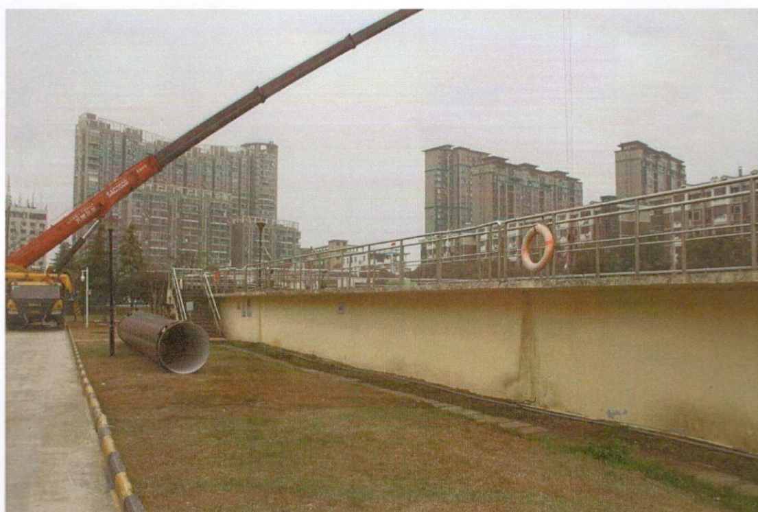
照片二：现场护栏
